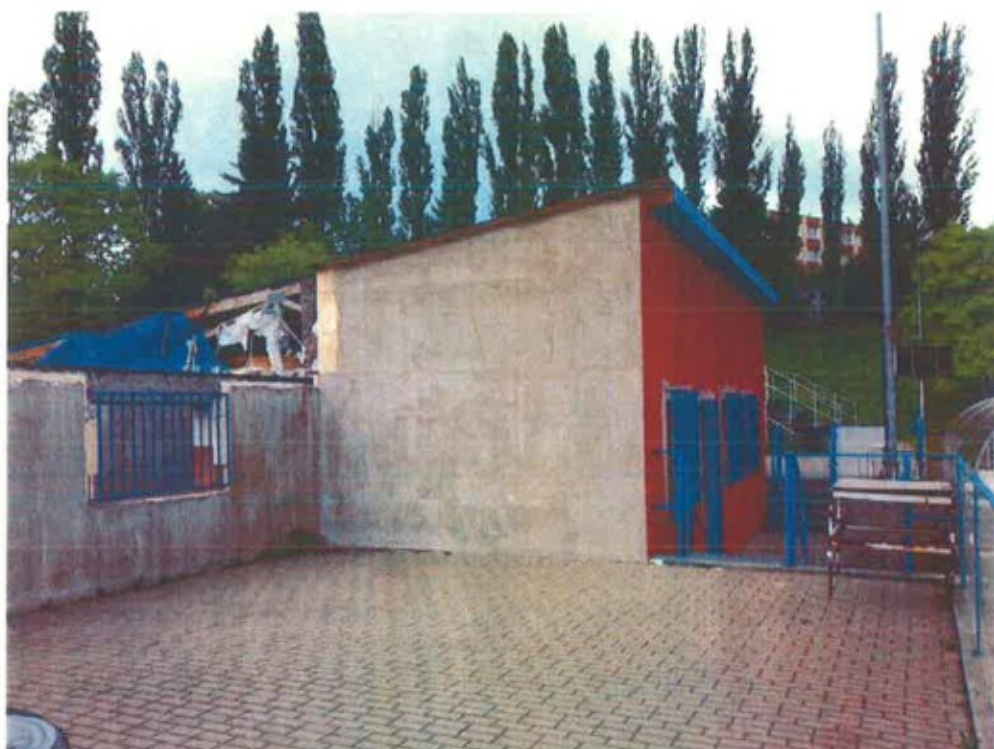
Pohled z levé tribuny na prostřední část budovy, která je i zastřešena
