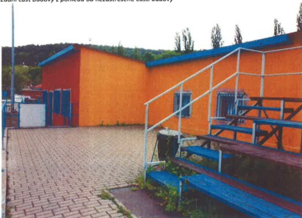
Pohled z pravé tribuny na zastřešenou část stavby
