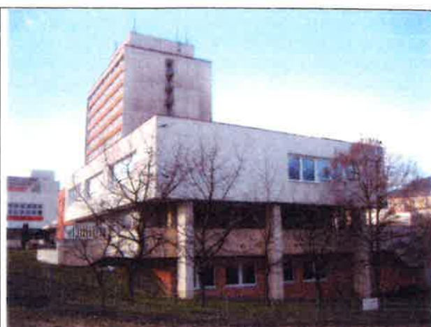
Obr. 08. Jihozápadní a jihovýchodní průčelí části „B“. Na snímku je patrné osazení stavby na svahu k ulici Hoření.
