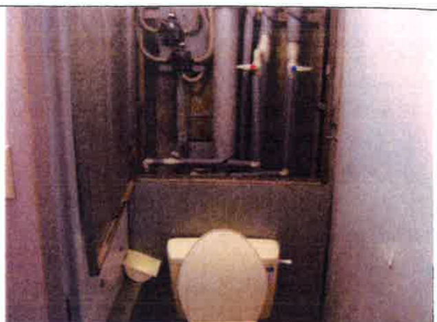
Obr. 14. Součástí každého pokoje je sociální vybavení záchodem s mísou WC, na který navazuje instalační šachta.
