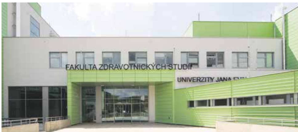
Nová budova FZS UJEP
